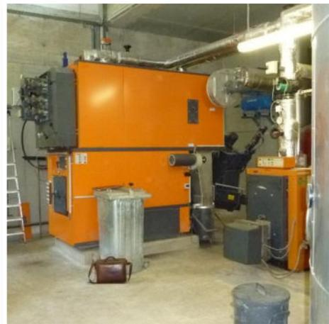
Abb. 33: Holz-Hackschnitzelkessel
